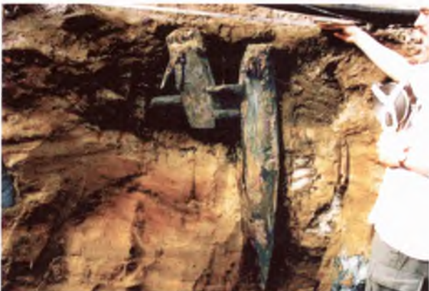
Abb. 16: In den sandigen Untergrund gerammter Eichenpfahl als Teil der Brückenkonstruktion an der heutigen Maxbrücke (Foto: AAF).
