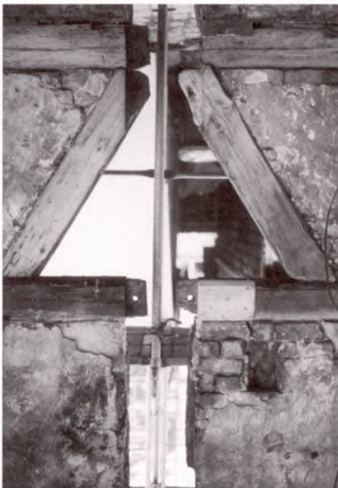
In der Pfarrscheune mußten viel Gebälk und viele Stützen ausgewechselt werden.
