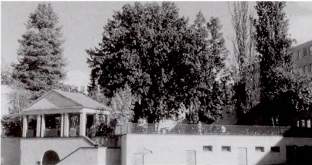
Das sind die Reste des ehemaligen Kurgeländes, die auch nach dem neuerlichen Gebäudeabriß geblieben sind: der Kurpark, der Pavillon und darunter die gefaßte Kurquelle. Sie werden Bestandteile des künftigen Uferparks sein. Foto: W. Mayer.
