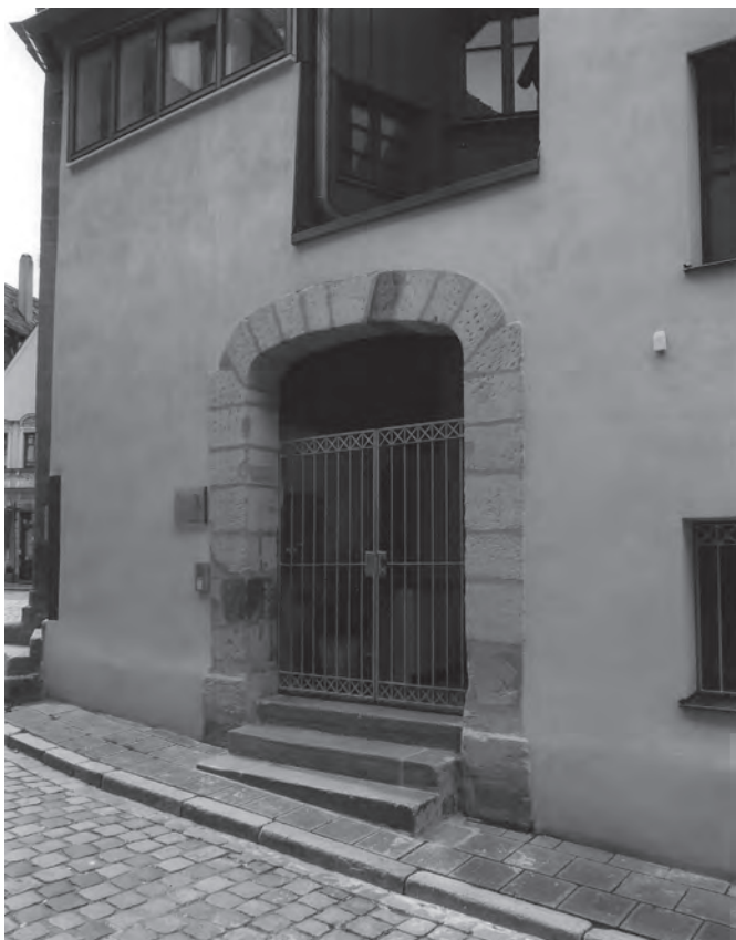
Die neue Toranlage. (Foto: A. Bär)
