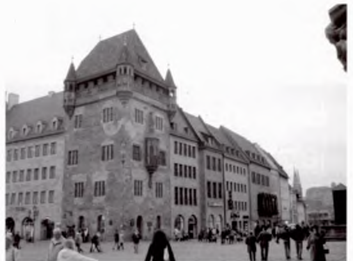
Das Nassauerhaus gilt als einziges in Nürnberg erhaltenes Beispiel eines mittelalterlichen Turmhauses. Von 1973 bis 1978 wurde das Nassauerhaus von Karstadt quasi umbaut. Die Fassadengestaltung löste zuvor leidenschaftliche Diskussionen aus. Zur Vermeidung irreversibler Bausünden einigte man sich auf die konventionelle Sandsteinfassade. In Fürth ist man traditionell weniger vorsichtig. Foto: A. Mayer.
