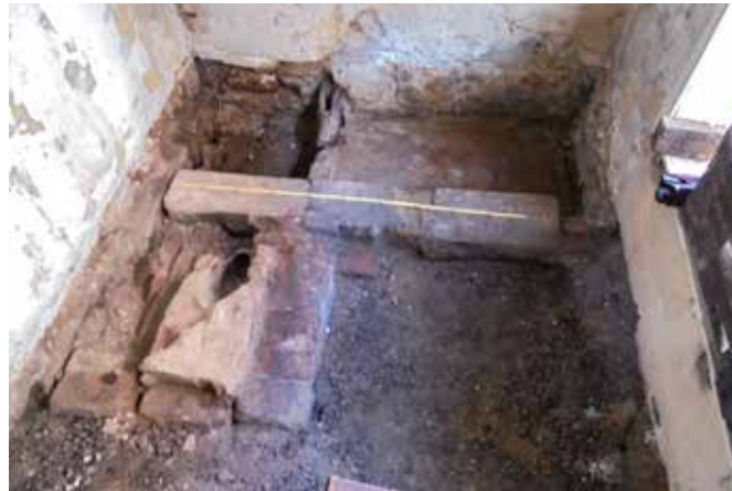
Abb. 1 a Die freigelegten Sanitärrelikte
