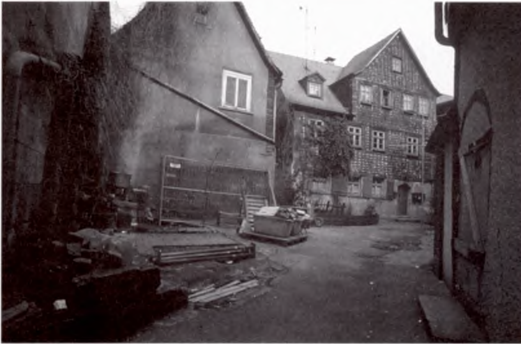
Trauriger Anblick in der Pfarrgasse: Auf der eine Seite stehen seit Jahren die Häuser eingerüstet, auf der anderen Seite (hier links im Bild) wird das von uns mühsam gestaltete und aufgewertete Fleckchen von einem Bauherren als Bauschuttdeponie mißbraucht. Foto: A. Mayer.
