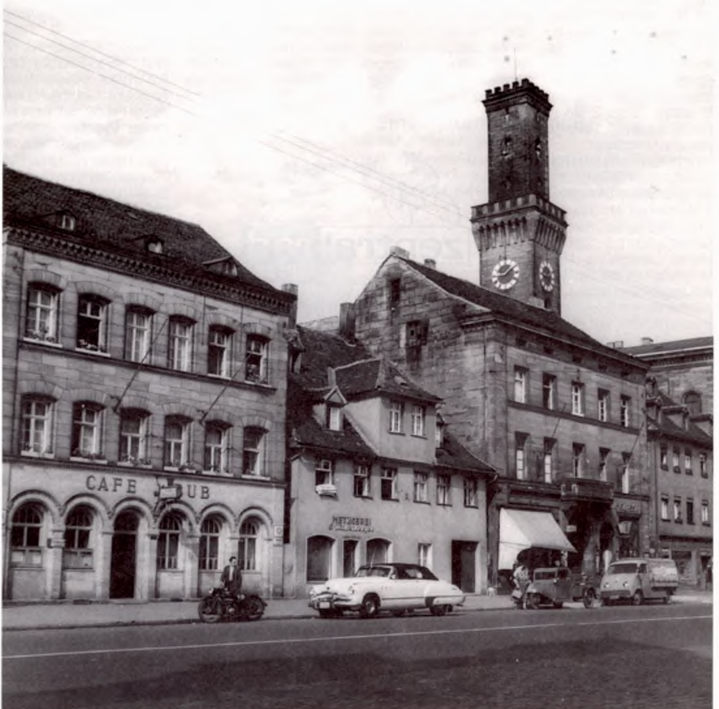
Von links nach rechts: Königstraße 96 (Café Bub, Fassade 1845 vorgeblendet), 94 (ehemalige Rote Schmiede, 1714 erbaut), 92 (spätklassizistisch, 1843 erbaut), 90 (1705 erbaut, 1896 und 1930 Erdgeschoß verändert) und 88 (Rathaus, 1840 - 1850 erbaut). Der italianisierende Rundbogenstil steht als Bezug zwischen Rathaus und Café Bub (heute: Caesar). Aufnahme vom 2. August 1952. Foto: Ferdinand Vitzethum.
