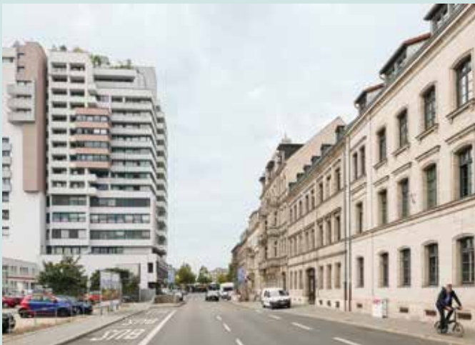
Bahnhofcenter: Dialog mit der historischen Bestandsbebauung Fehlzanzeige...
