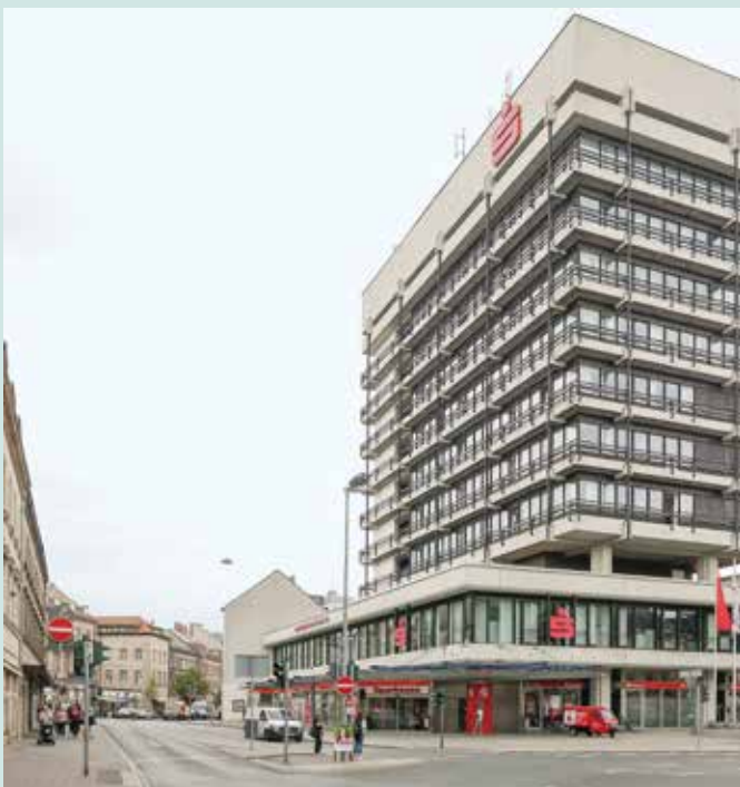
Die Stadtparkasse: Zur Erbauungszeit (und teilweise heute noch) von den „Experten“ hochgeschätzte Spektakelarchitektur ...
