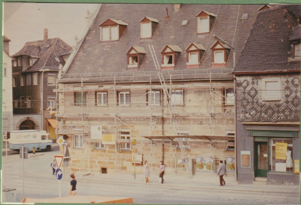
Der "Goldene Schwan", das letzte Überbleibsel, das noch daraufhin deutet, daß sich in dem Haus früher eine Gaststätte befunden hat.
