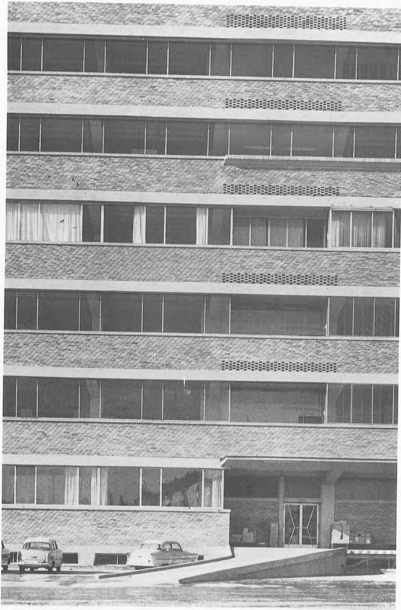
Ansicht Ostseite, Verladerrampe
