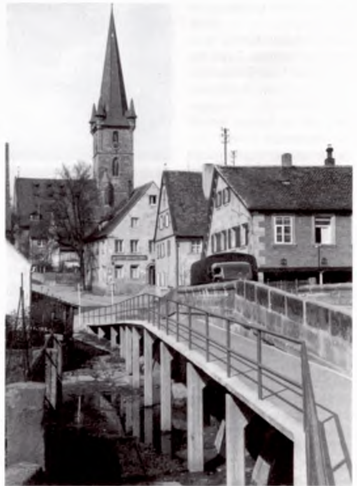
Farnbachbrücke (Abbruch 1992) in der Regelbacher Straße. Foto: Wolkenstörfer.
