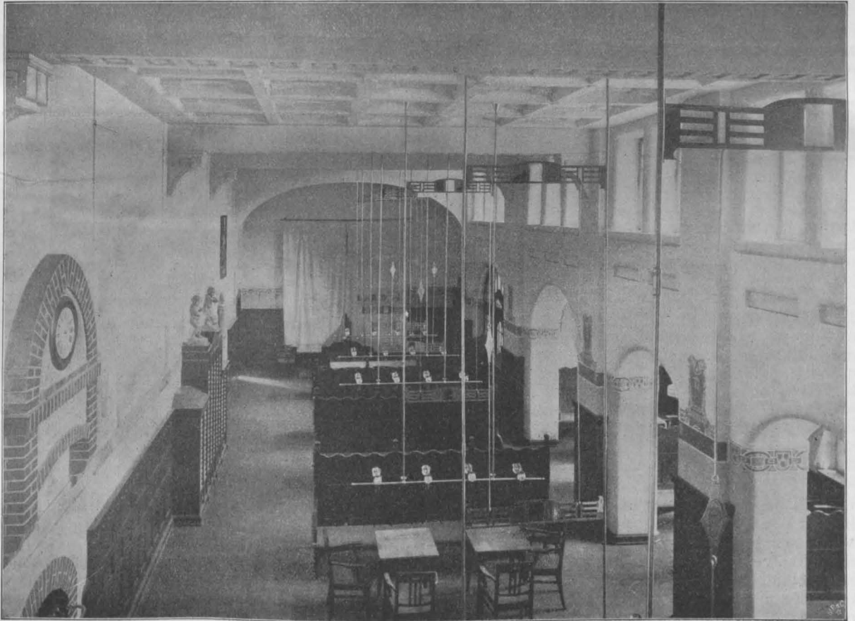
Das Berolzheimerianum (Volksbildungsheim) in Fürth. Arch.: Stadtbbr. Otto Holzer, Fürth. Ansicht des Vortrags- und des Lesesaales.
